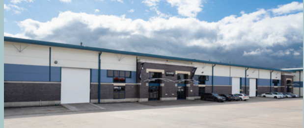
Teckentrup UK Limited, Warrington
